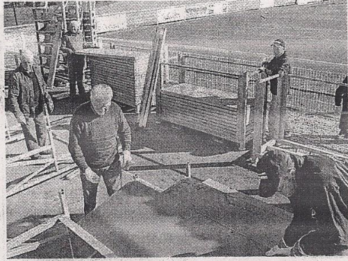
Le montage des tribunes : une mécanique parfaitement rodée au fil des années.
